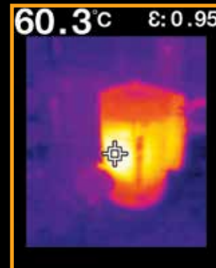
Surchauffe des équipements mécaniques
